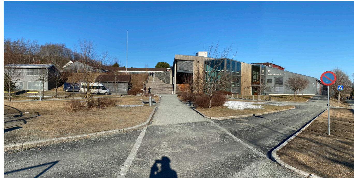
Adkomst - Eksisterende situasjon
